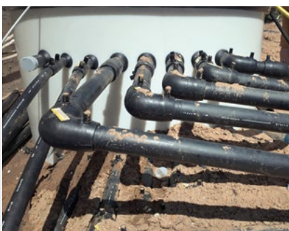
Abb. 5 Die einzelnen Kreise wurden mit dem Verteilerschacht verbunden.
