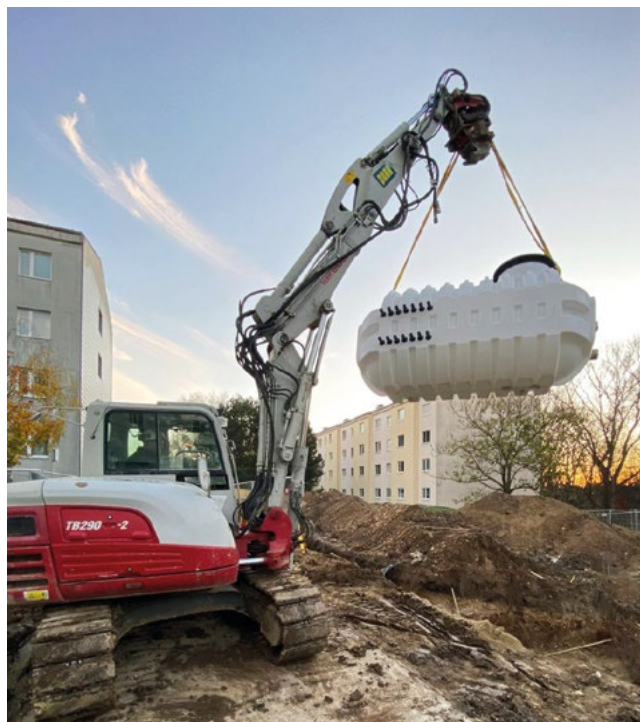
Abb. 4 Einbau eines GN-X2 Verteilerschachts auf der Baustelle.
