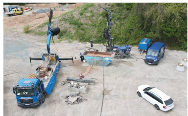
Abb. 1 Baustelleneinrichtung der Firma BauGrund Süd.
