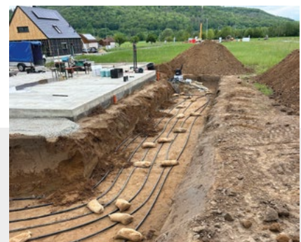
Abb. 3 Verlegung eines Kollektors im Neubau.
