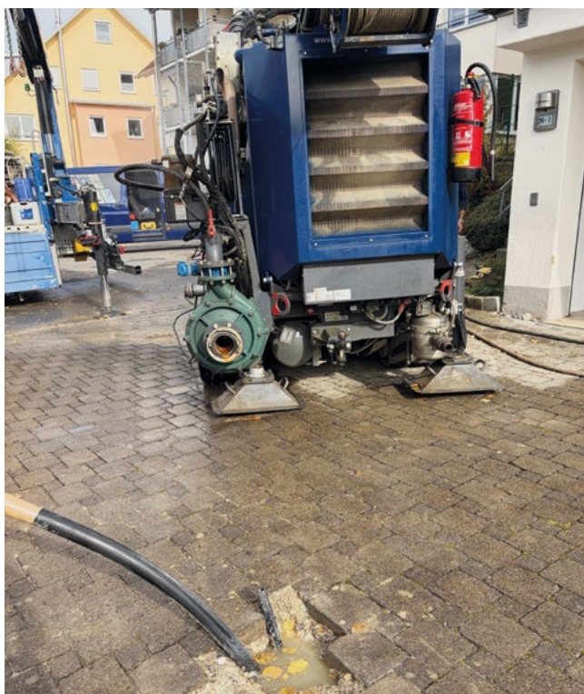
Abb. 5 Nach dem Bohren ist vor dem Anschliessen.
