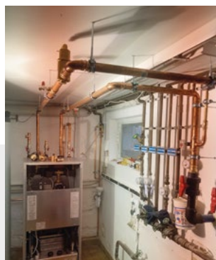
Abb. 2 Die Wärmepumpenmontage im Heizraum.
