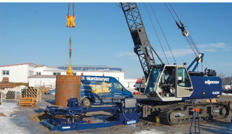
Abb. 4 Verrohrungsdrehtisch für einen Seilbagger unseres Kunden BauGrund Süd.
