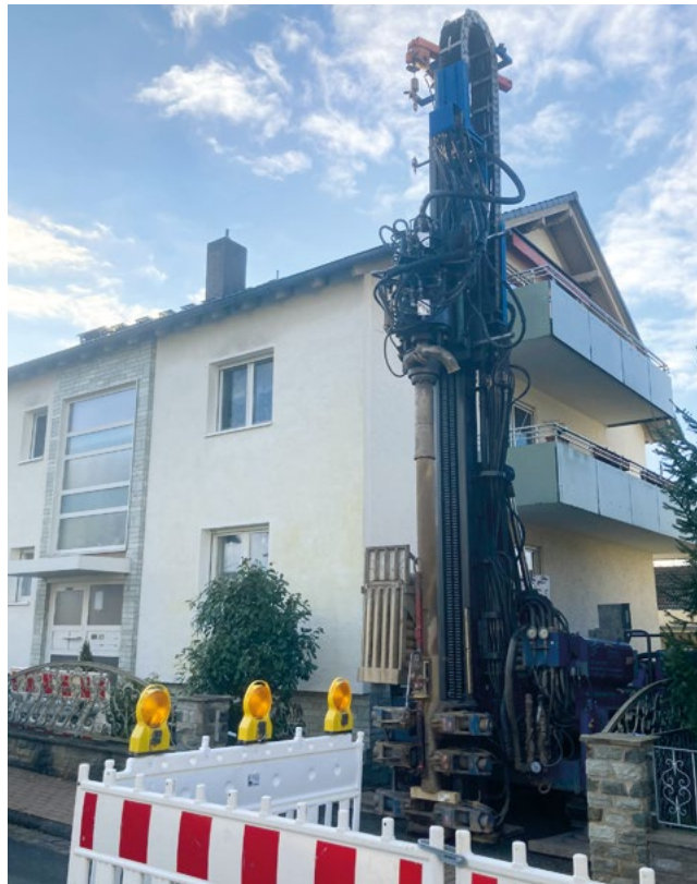
Abb. 5 Die laufenden Bohrarbeiten in der Hofeinfahrt - drei Bohrungen á 99 Meter im Festgestein wurden durchgeführt.
