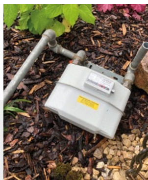
Abb. 3 Gasanschluss raus - Erdwärme rein.
