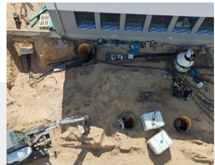
Abb. 3 Ein weiterer Tank befindet sich auf der anderen Gebäudeseite.
