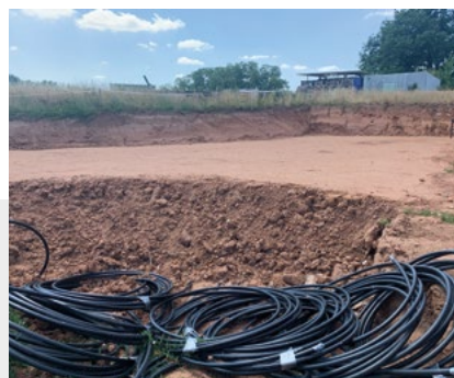
Abb. 8 Ein Flächenkollektor nach der Verlegung, teilverfüllt.
