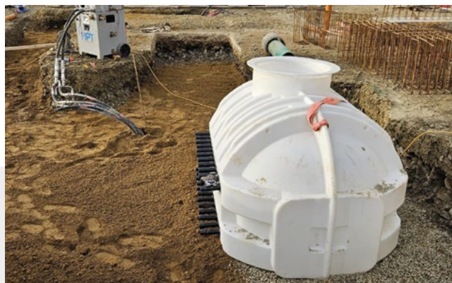
Abb. 5 Einbau eines GN-X2 Verteilerschachts auf der Baustelle.
