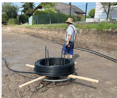
Abb. 2 Leichtes Verlegen der Rohre mit einer Haspel.
