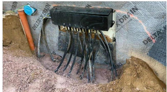
Abb. 6 Eine Variante des Hausanschlusses: Der Wandanschlusschacht.
