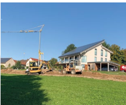
Abb. 1 Baustelleneinrichtung für den Bau eines Flächenkollektors.
