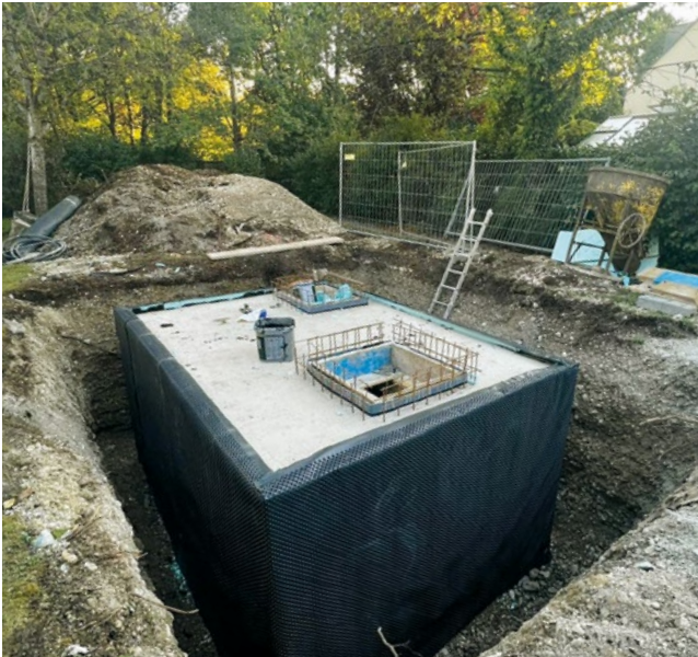
Abb. 2 Brunnenstube (Schacht) in der Blumenauer Straße.
