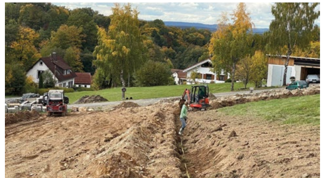
Abb. 5 Verfüllen des Kollektors im Graben, ebenfalls mit Warnband.
