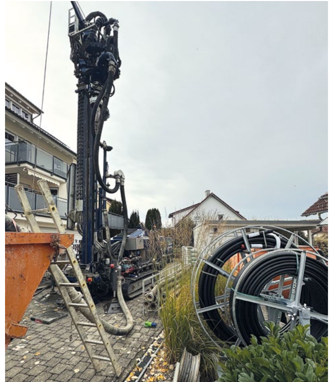
Abb. 3 Die Baustelleneinrichtung mit Bohrgerät, Mulde, Haspel und Kompressor.
