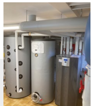
Abb. 4 Die Installation ist abgeschlossen.
