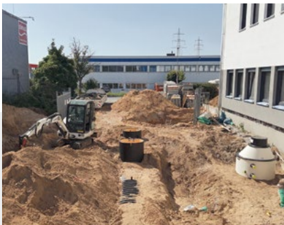
Abb. 1 Blick auf die Baustelle mit Verteilerschacht.
