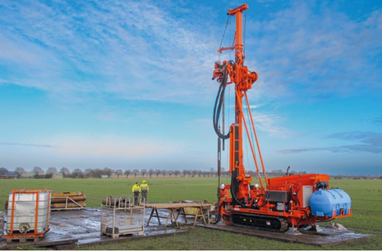
Abb. 7 Bohrplatz im Schutzgebiet mit entsprechender Schutzeinrichtung.
