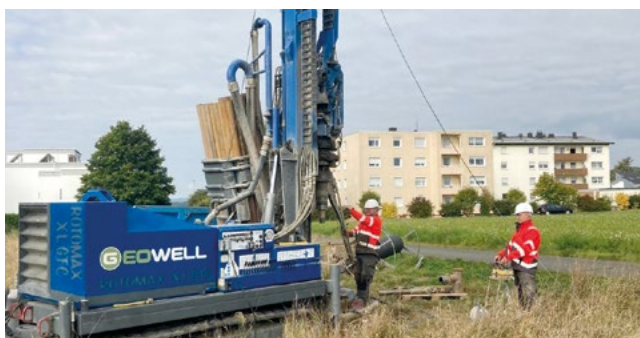
Abb. 1 Modernes Bohrergerät von Geowell im Einsatz.
