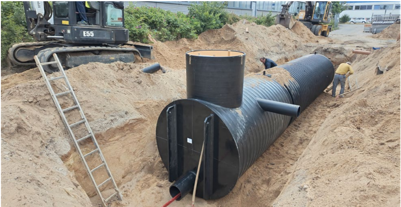
Abb. 4 Der THERMTANK beim Einbau auf dem Werksgelände der Firma FRANK in Mörfelden-Walldorf.
