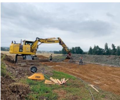
Abb. 7 Abdecken der Kollektorrohre mit Sand.
