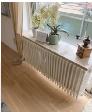
Abb. 1 Alte Heizkörper mit neuen Ventilen.
