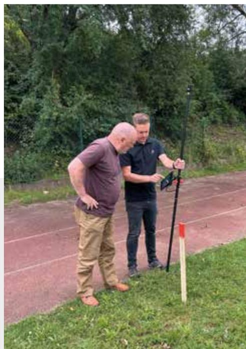
**Abb. 2** Bohrunternehmer Reinhard Westphal beim Einmessen der Bohrpunkte.
