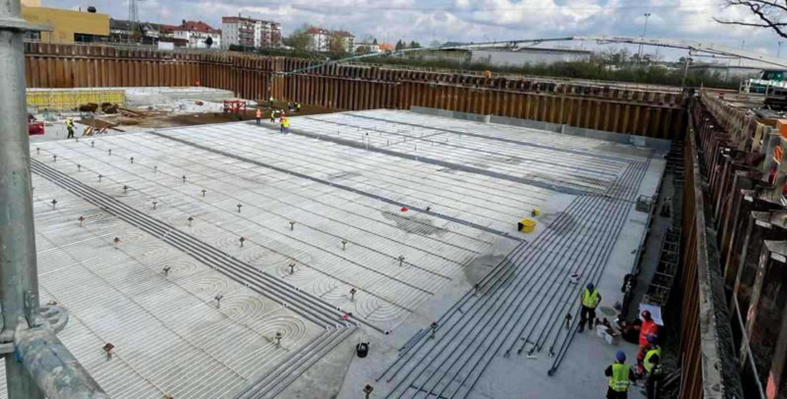
Abb. 1 Verlegung des Wärmetauschers auf dem Lagarde-Campus im oberfränkischen Bamberg.
