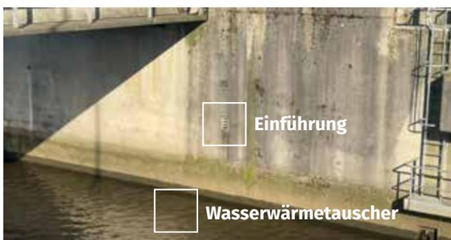
Abb. 1 Die Einbauposition im Fluss Hunte.
