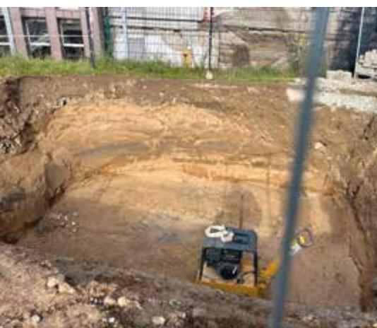
**Abb. 16** Vorbereitung der Grube für die Verteilerschächte
