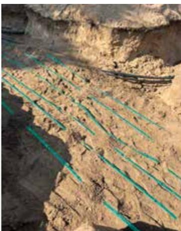
Abb. 20 Warnband zum Schutz der verlegten Anbindeleitungen.
