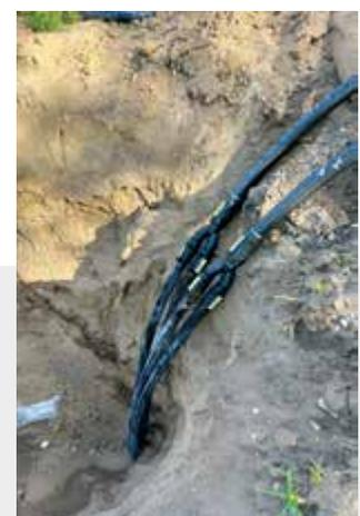
**Abb. 18** Erdwärmesonden mit Rohrzusammenführungen
