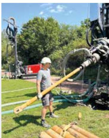
Abb. 4 Einsetzen des Bohrmeißels an der Bohranlage.
