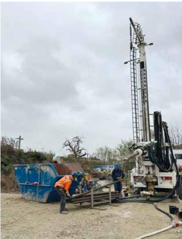
**Abb. 2** Das Bohrgerät beim Gestängewechsel.
