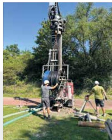
Abb. 10 Einbau der Erdwärmesonde.
