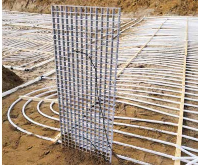
Abb. 1 Gitter mit Messtechnik vor und nach dem Einbau. Fotos: FAU
