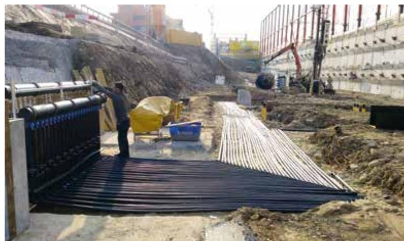
Abb. 1 Eine 22-fach Verteileranlage für die Baustelle in Malzers.
