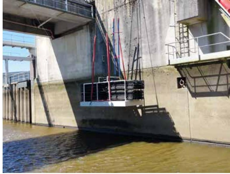
**Abb. 2 und 3** Blick auf die Wärmetauscher, die mittels 80-Tonnen-Mobilkran an die vorgesehene Einbauposition gehoben wurden.
