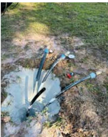
Abb. 12 Fertig verfülltes Bohrloch mit Fischer GeoSolid 240 HS
