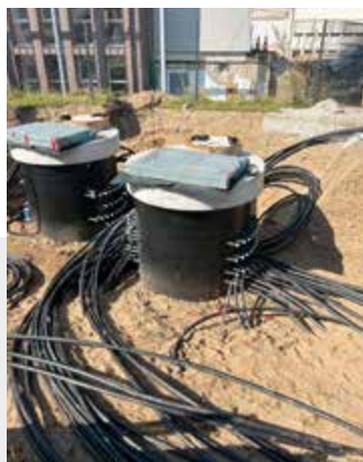
Abb. 21 Verteilerschächte mit angeschweißten Anbindeleitungen.
