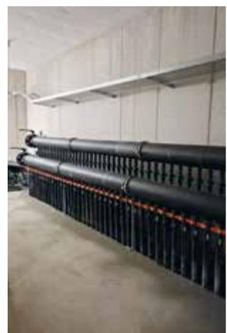
**Abb. 5-7** Für den Neubau in Wädenswil wurde eine Verteileranlage mit 66 Abgängen mit einer weiteren mit 19 Abgängen kombiniert.
