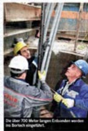
Die über 700 Meter langen Erdsonden werden im Bereich eingeleitet.
