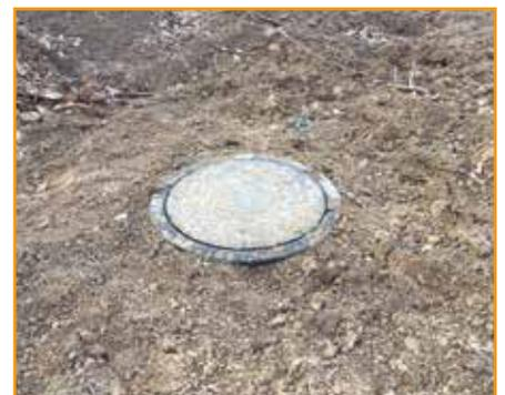
*Der Schachtdeckel (150 KG belastbar) zeigt den Standort des Verteilerschachtes. Mehr ist von der Erdwärmeanlage nicht mehr zu sehen.*
