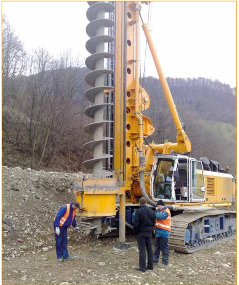
*Ein Großdrehbohrgerät mit Schnecke zur Pfahlgründung.*
