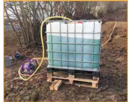
*Wärmeträgerflüssigkeit für die Befüllung der Anlage bis -16°C.*
