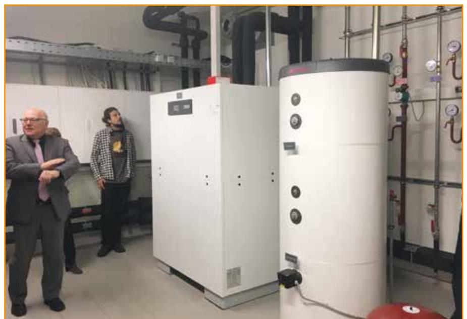
Ein Blick in den Technikraum. Als Wärmepumpe wurde hier ein Gerät der Firma Weishaupt verbaut.
