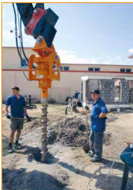
Eine Hohlbohrschnecke mit Bohrmotor.
