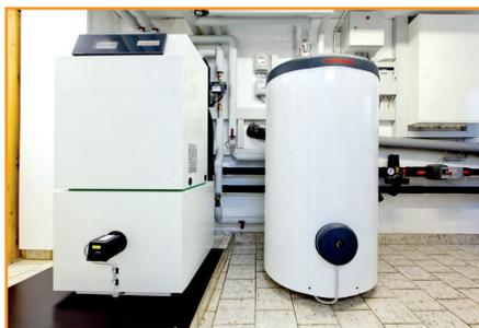
Blick in den Heizungskeller mit der Wärmepumpe mit Pufferspeicher.
