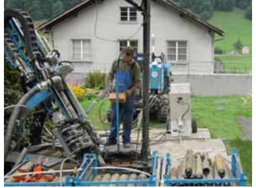
Durchführung einer Erdwärmesondenbohrung
